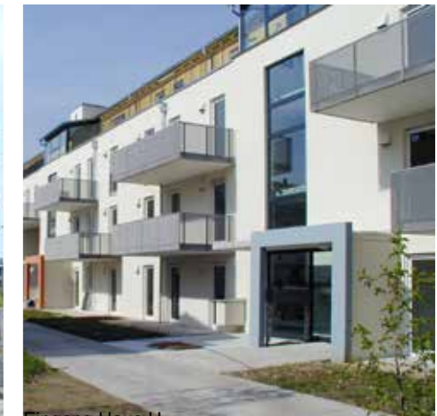
Eingang Haus H
