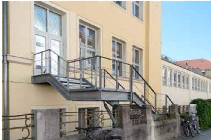
Fluchttreppe Hörsaal Geb. B
