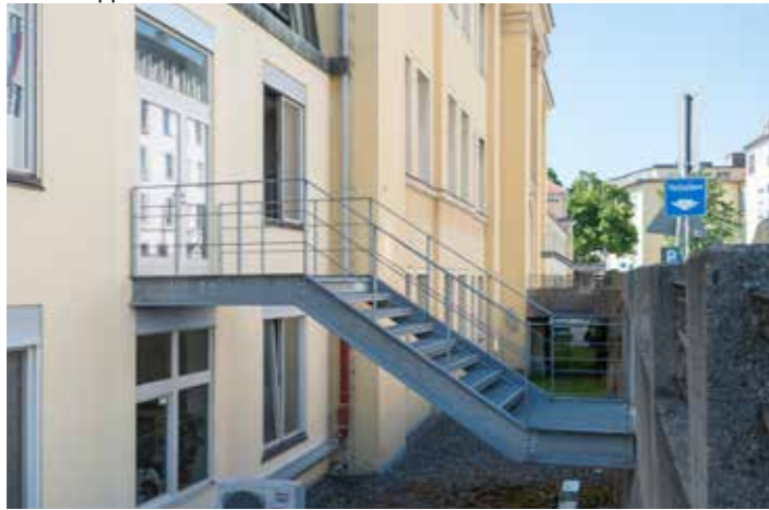
Fluchttreppe Sammlung Geb. C
