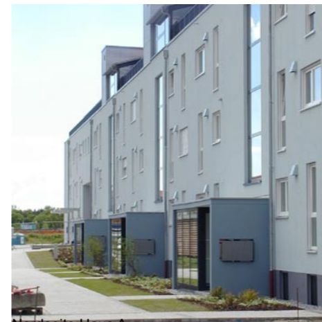
Nordseite Haus A
